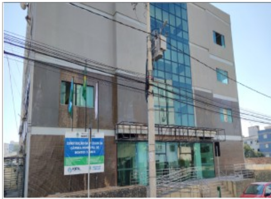
Foto 1: Fachada Frontal. Serviço de demolição, impermeabilização e recomposição
