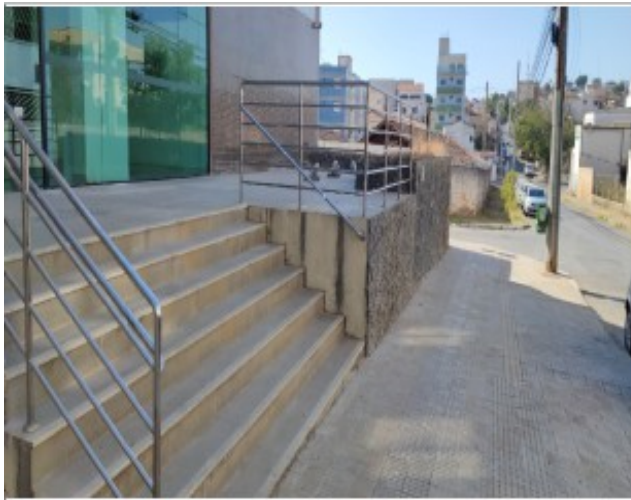
Foto 5: Detalhe de local que será impermeabilizado e recomposto
