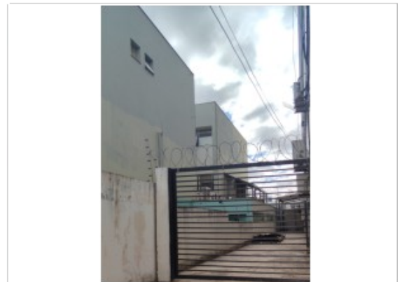
Foto 4: Área externa lateral a impermeabilizar
